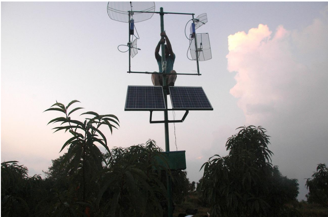
ပုံ CSD 7 : Kumaon ကွန်ယက်တွင် နေရောင်ခြည် စွမ်းအင်သုံး ထပ်ဆင့်လွှင့်တင်ဆင်ပုံ
