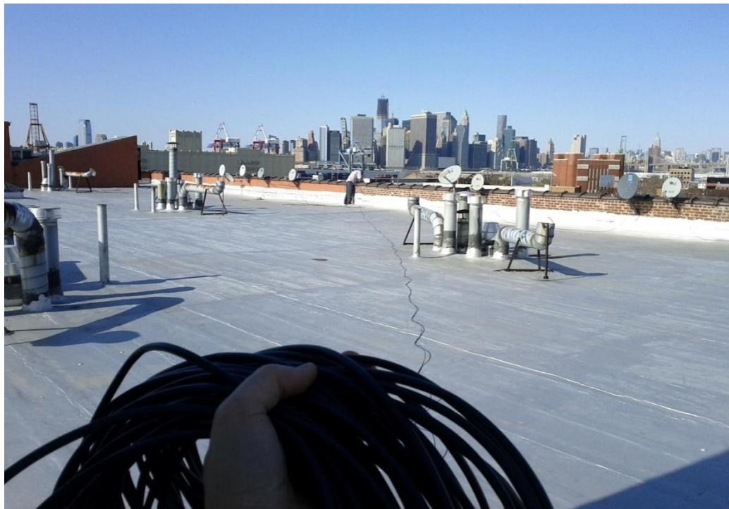
ပုံ CsOTI 5 : Coffey ပန်းခြံ၏ မြောက်ဘက်ရှိ အဆောက်အဦး အဖိုးပေါ်တွင် node တစ်ခု တပ်ဆင်ရန် ကြိုးများ ပြင်ဆင်နေပုံ
