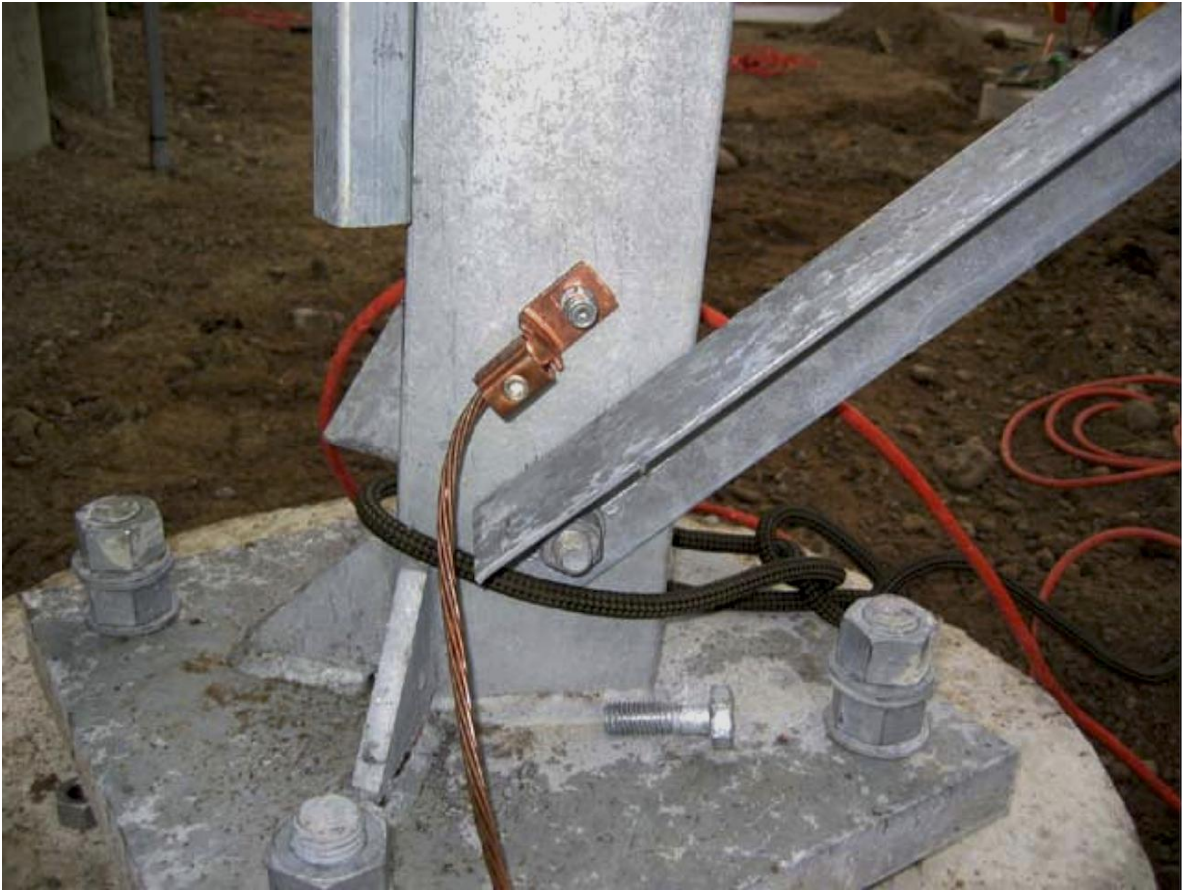
ပုံ HW 3 : မြေကြီးအတွင်းသို့ နှစ်မြှုပ်ထားသည့် လေးလံသော ကြေးနီဝါယာကြိုးတစ်ခုနှင့် တာဝါတိုင်တစ်ခုပုံ
