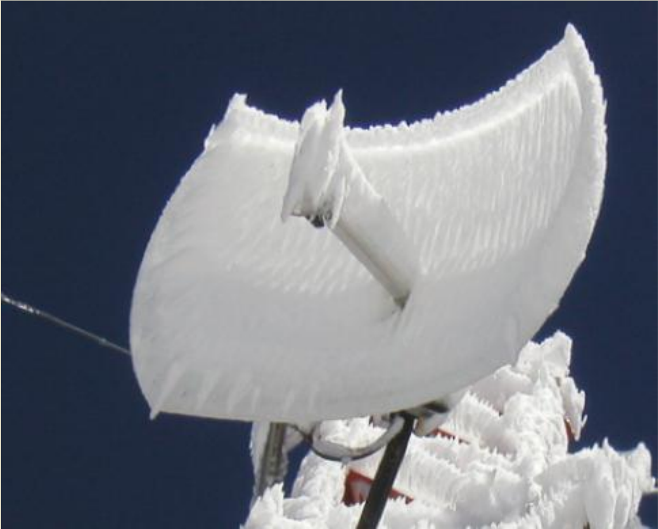
ပုံ ATL 17 : parabolic grid ကောင်းကင်တိုင် အပေါ်သို့ ရေခဲများ၏ သက်ရောက်မှု
